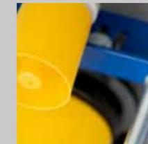
Mit der gelben Mauerhilfe und den Bauverschlusskappen wird der Spülkasten beim Einbau vor Baustaub geschützt. Diese Teile werden ganz oder teilweise entfernt.
